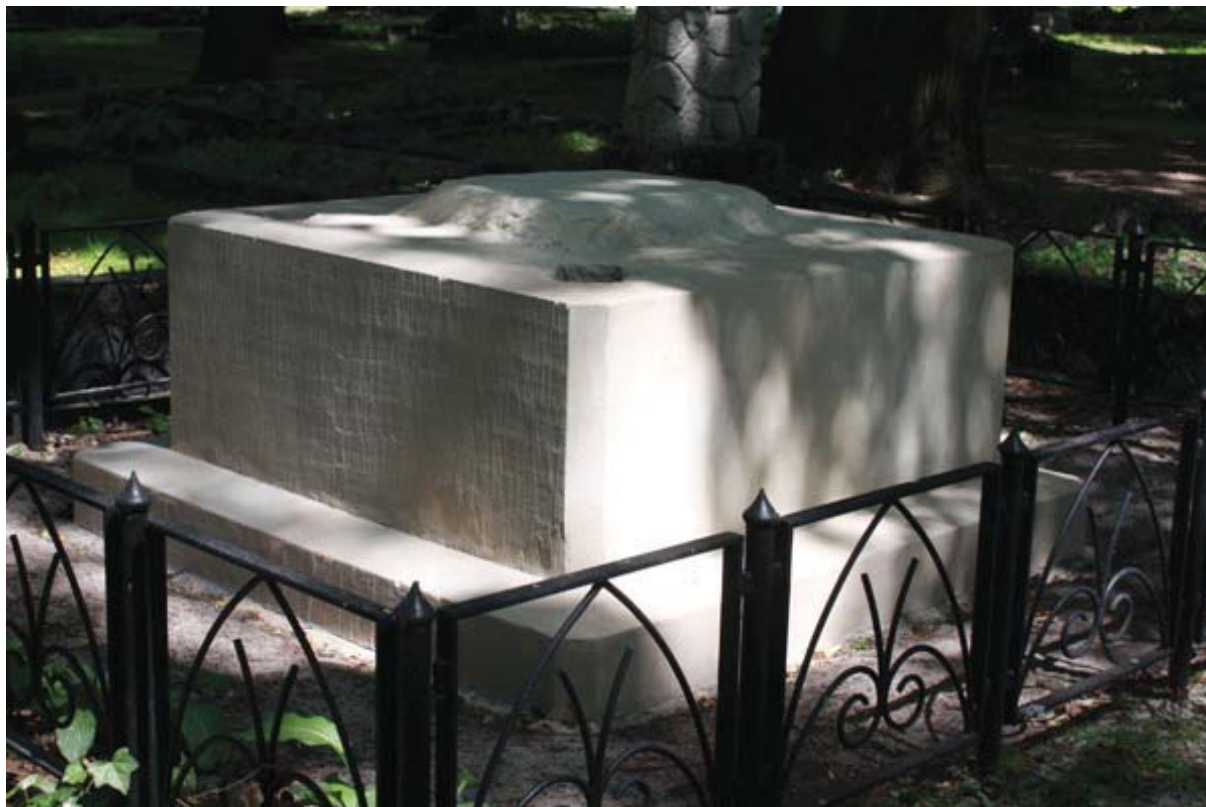
Fot. 25: Cokół po konserwacji.
