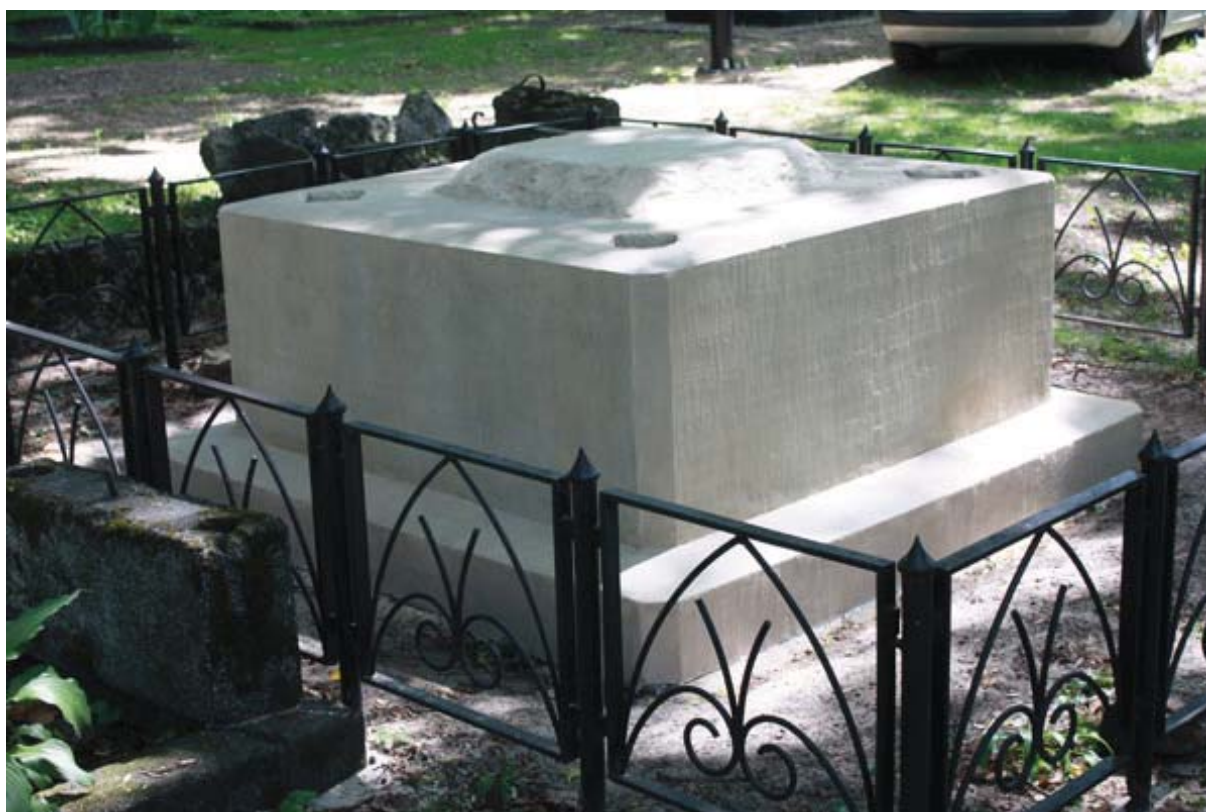
Fot. 26: Cokół po konserwacji.
