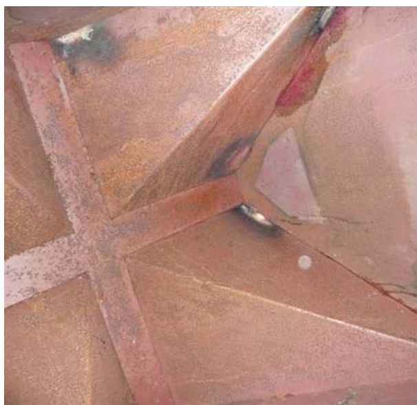
Fot. 18: Wnętrze kapliczki przed demontażem.
