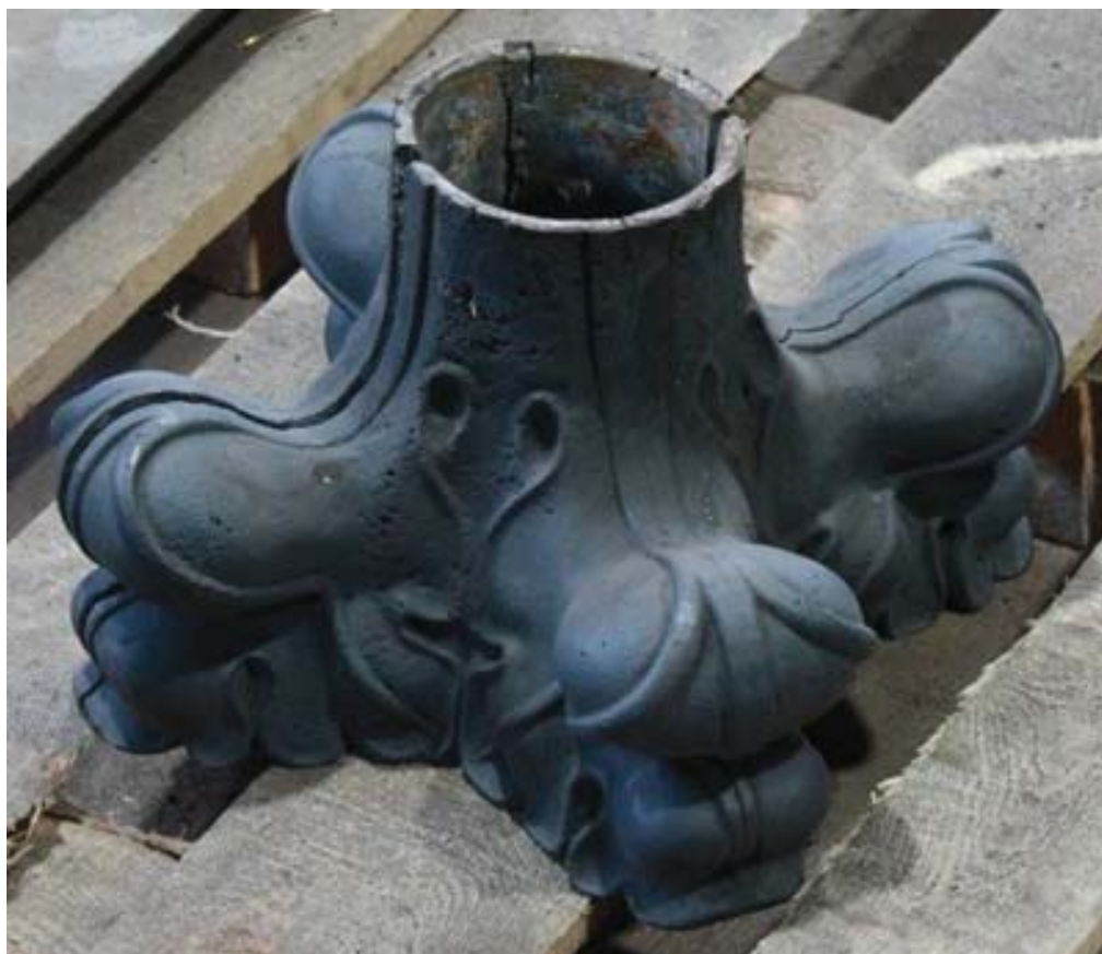
Fot. 12 – 14: Części kwiatonu po zdemontowaniu.
