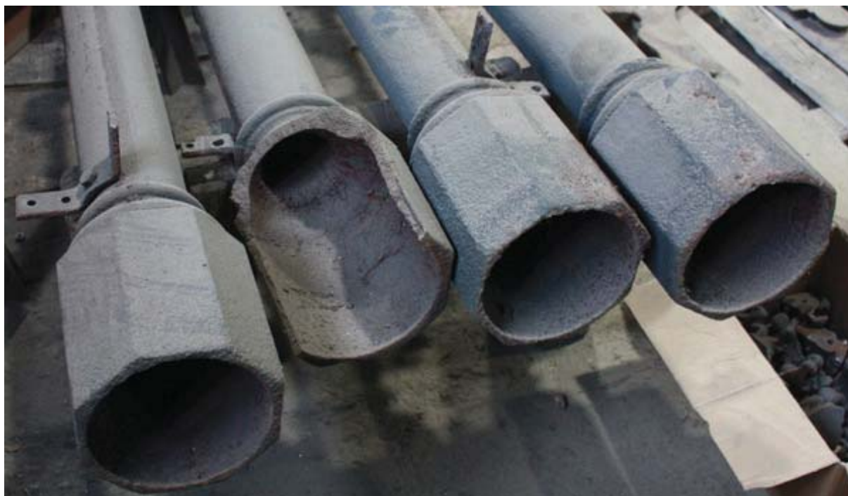
Fot. 16: Podstawy kolumn, widoczny duży ubytek w jednej z nich oraz przykręcone zaczepty do mocowania kwater.
